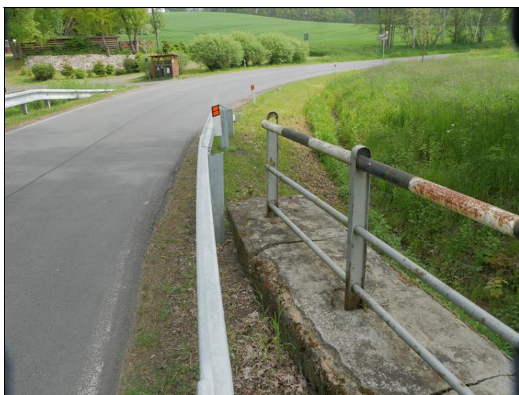
degradace betonu římsy; nečistoty v krajích
