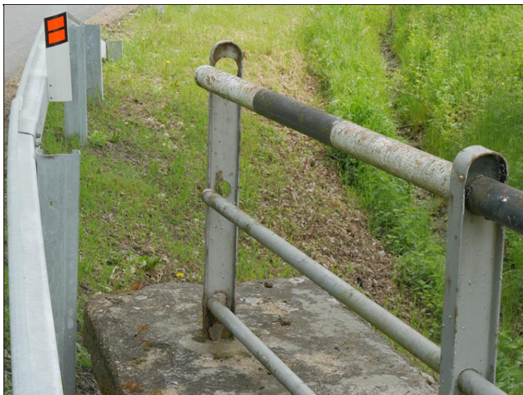
vodorovná madla nejsou vpravo za OP1 ukotvena v posledním sloupku
