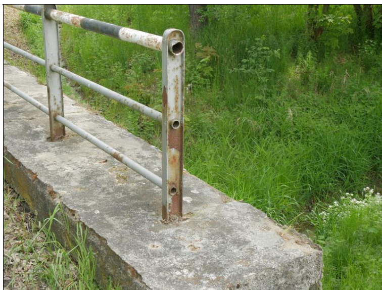
koroze ocelových prvků zábradlí
