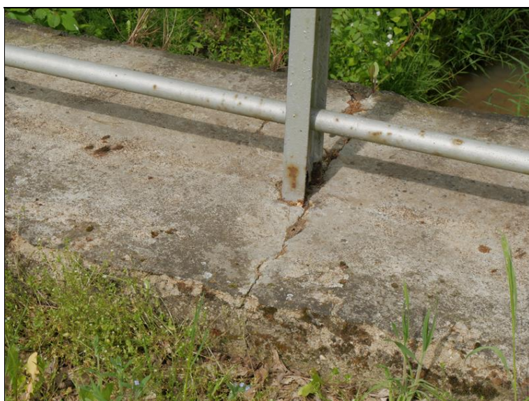
trhliny v římse mostu
