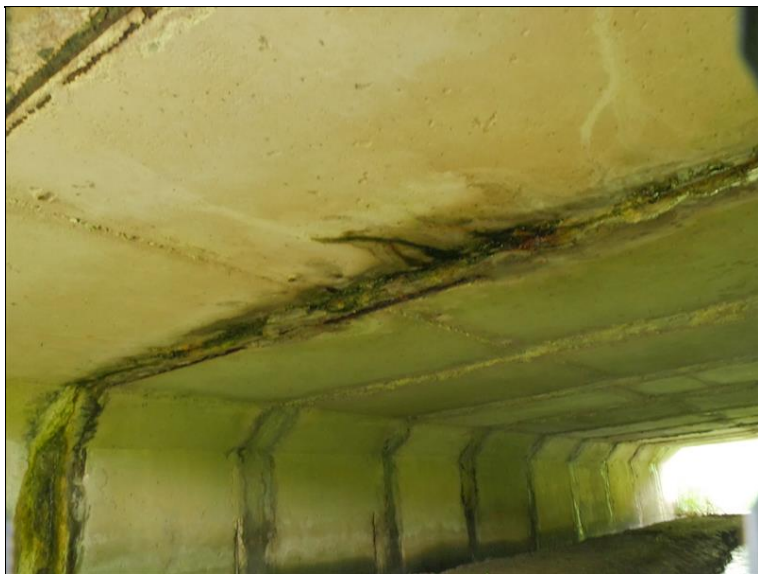
zatékání do spár mezi prefabrikáty
