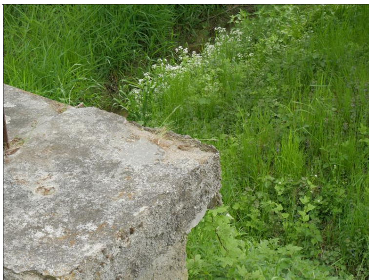
degradace betonu římsy
