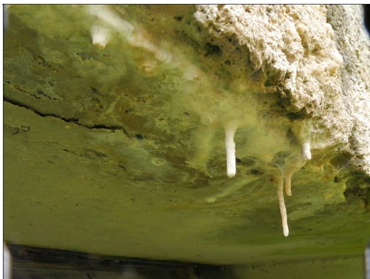
krápníkové výluhy cementového mléka na pravém kraji NK; olupující se krycí vrstva betonu
