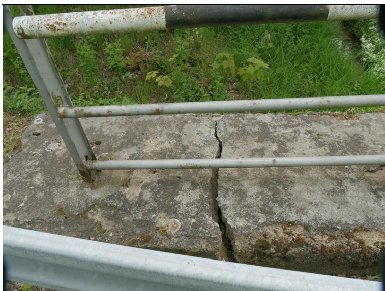
trhlina v římse mostu - pokles křídla vpravo OP2
